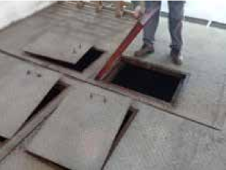
Cámaras de separación por triple filtrado del agua, aceite y barros
